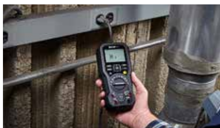
Controleren op spanning met contactloze spanningszoeker
